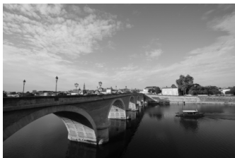
Korjaus ei käytössä
